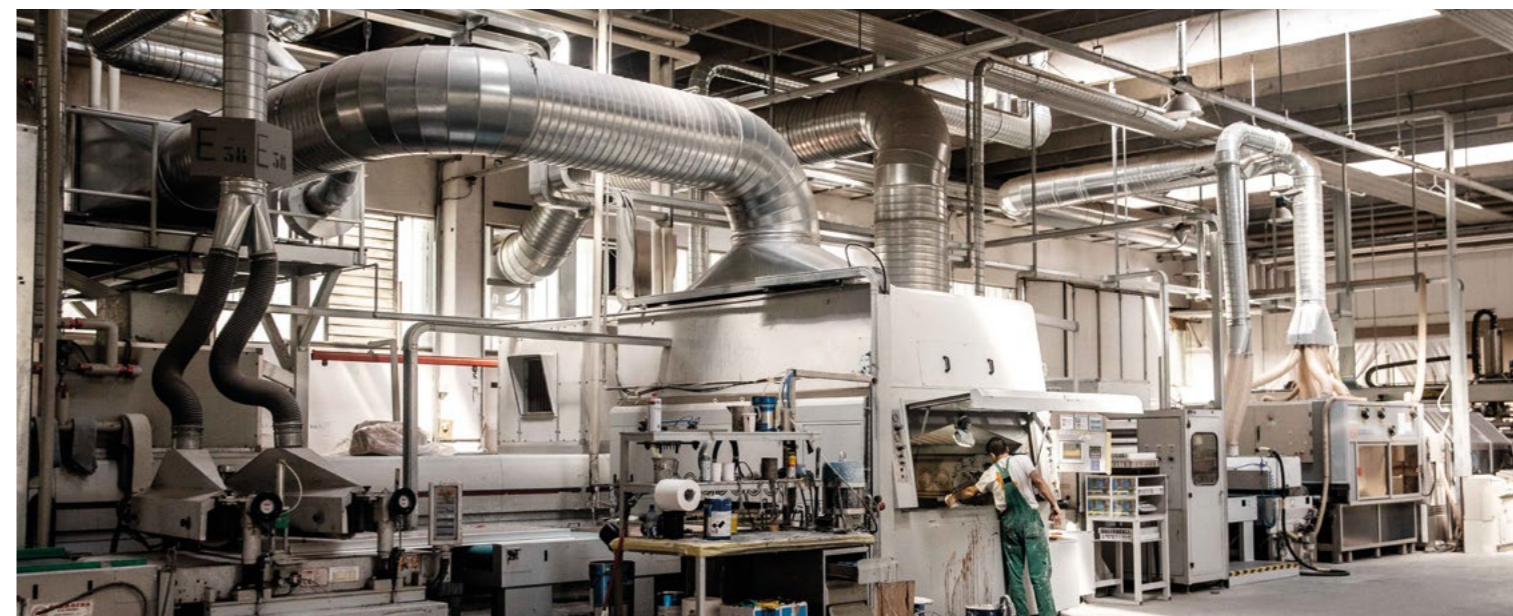
Doppia linea di verniciatura con forno a infrarossi con sette trattamenti sui pannelli Silvelox per completare la reticolazione della vernice. Double painting line with infrared oven with 7 treatments to complete the paint fixing on Silvelox panels.
